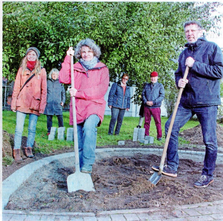
Die Arbeiten haben begonnen: Die Gemeinde Ascheffel legt einen Ideengarten zum Schutz von Insekten an. Bürgermeister Jörg Harder (vorne von rechts) und Arbeitgruppensprecherin Sabine Bogner hoffen mit Justina Möllers (von links), Brigitte Bergendahl, Irmgard Winterstein, Marion Zimmermann und Karl-Heinz Fiebig, dass die Fläche wie geplant bis Ende Oktober umgestaltet ist. FOTO: RAINER KRÜGER
